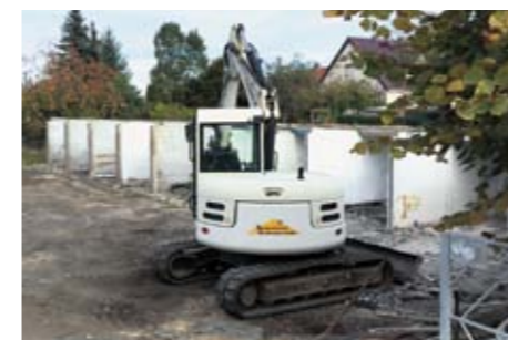
Neubau Garagenkomplex Preuskerviertel
