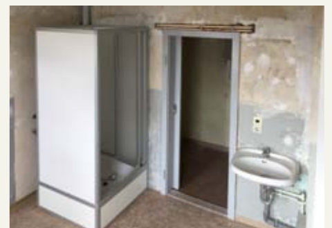
Damal wars – Duschkabine und Waschbecken in der Küche.
