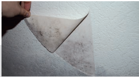
Feuchte Wände, sich lösende Tapeten, muffiger Geruch und schwarzbraune Flecken an Wänden und Decken sind die Kennzeichen für den unerwünschten Schimmelpilzbefall. Bekannt sind ca. 10.000 Schimmelpilzarten, davon können ca. 100 Arten auch im Wohnbereich vorkommen.
