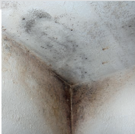
Feuchte Wände, sich lösende Tapeten, muffiger Geruch und schwarzbraune Flecken an Wänden und Decken sind die Kennzeichen für den unerwünschten Schimmelpilzbefall. Bekannt sind ca. 10.000 Schimmelpilzarten, davon können ca. 100 Arten auch im Wohnbereich vorkommen.
