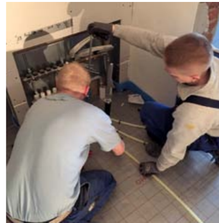
Simon Schiffner (li.) und Tilo Mommert von der Großenhainer Ausbau GmbH bei der Montage der Fußbodenheizung
