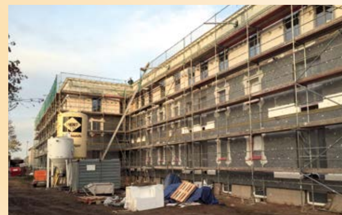
Im Oktober erfolgte die Aufstockung und Fassadendämmung
