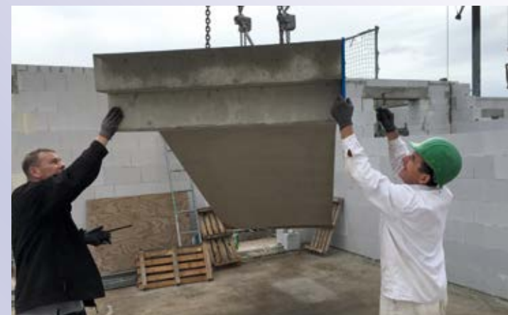
Einbau der neuen Treppenelemente mit Hilfe von Krantechnik
