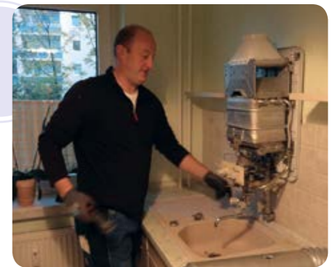
Herr Frank Böhme von der Firma J. Schwarz beim Rückbau der Gasdurchlauferhitzer. Bild li.: Alexander Sobock/pixelio.de
