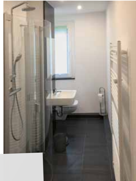
Im Bild sehen Sie ein altersgerecht umgebautes Bad mit ebenerdiger Duschfläche und barrierefreiem Durchgang.
